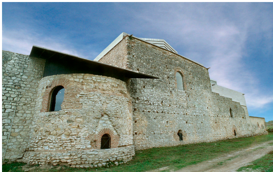
Façana principal i posterior de Centelles. Estat actual després de la restauració realitzada a inicis dels anys 90 del segle passat. Arxiu MNAT.
